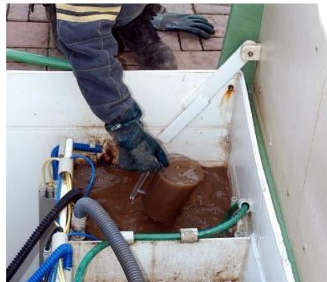
1. ČOV uvedeme do průtočné fáze, pokud tato fáze právě neprobíhá. (Zapneme dmychadlo a koncovku řídícího plováku přizvedneme tak, abychom nasimulovali zvýšenou hladinu v akumulaci).
